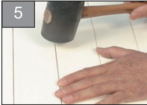
5 Затем панели соединяют между собой при помощи киянки. Проводя пальцем по стыку вслед за киянкой по мере продвижения, проверяют правильность соединения панелей. Если обнаружена выпуклость, следует остановиться, слегка развести панели, выровнять стык при помощи отвертки, затем продолжить работу.
