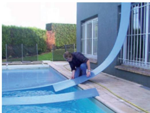
ПОСЛЕДНИЕ НЕСКОЛЬКО САНТИМЕТРОВ СОЕДИНЯЮТ ПРИ ПОМОЩИ КИЯНКИ, ДЕРЖА ПРИ ЭТОМ ПАНЕЛИ ПОД УГЛОМ 45 ГРАДУСОВ.°
